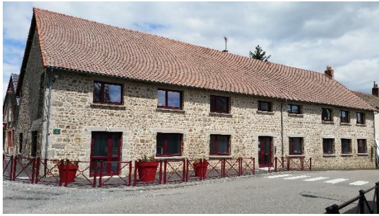
Entrée côté rue de la Nave (visiophone)
